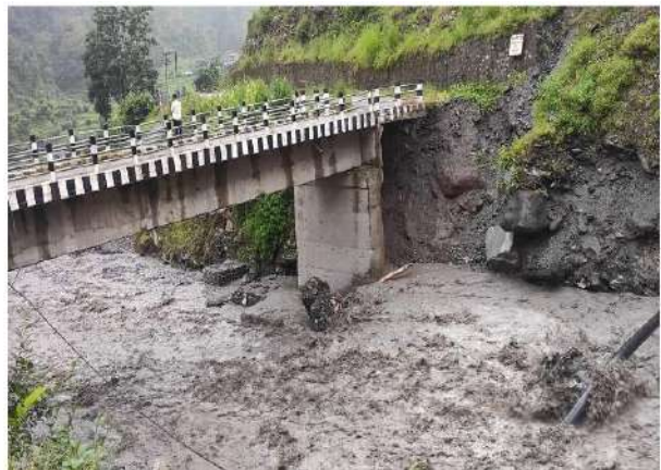
सरकारी निकायबाट दिगो विकासलाई चुनौती दिंदै निर्मित पक्कीपुल खोलाको कटानीले जोखिममा, मालिका, म्याग्दी
