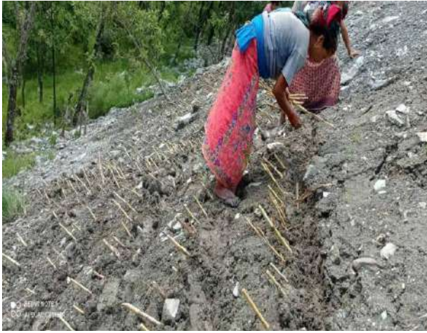
पहिरो तथा सडकपाखोमा लाईन मिलाएर नेपिएर घाँसको कटिड लगाउने तरिका
